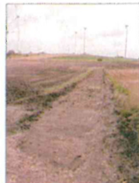
Rückbau eines nicht mehr benötigten Standortes. Er wird wieder Acker.
