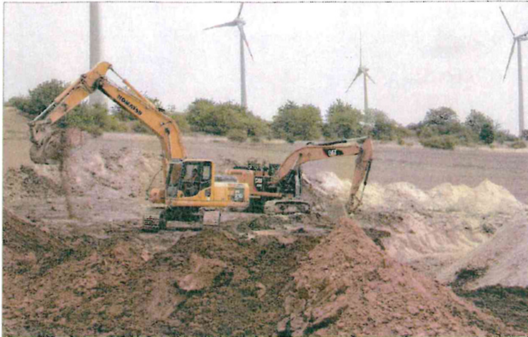
Bagger arbeiten auf dem Druiberg und bereiten den Bau weiterer Windkraftanlagen vor.
