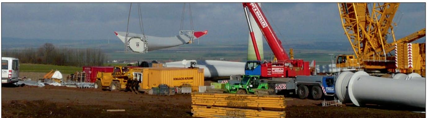
**Als letztes der drei neuen Windräder im Windpark Druiberg wurde Ende Februar die Maschine 26 errichtet. Hier lässt der Telekran gerade einen der 3 über 50 Meter langen Rotorflügel über die Baustelle schweben.**
