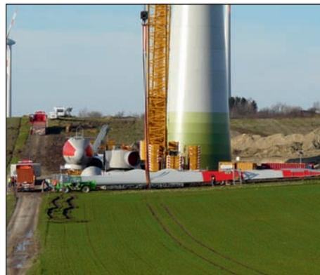
**Noch liegen der Generator und die drei je 40 Meter langen Flügel am Boden. Doch der gelbe Telekran wird sie in Kürze hochziehen.**
