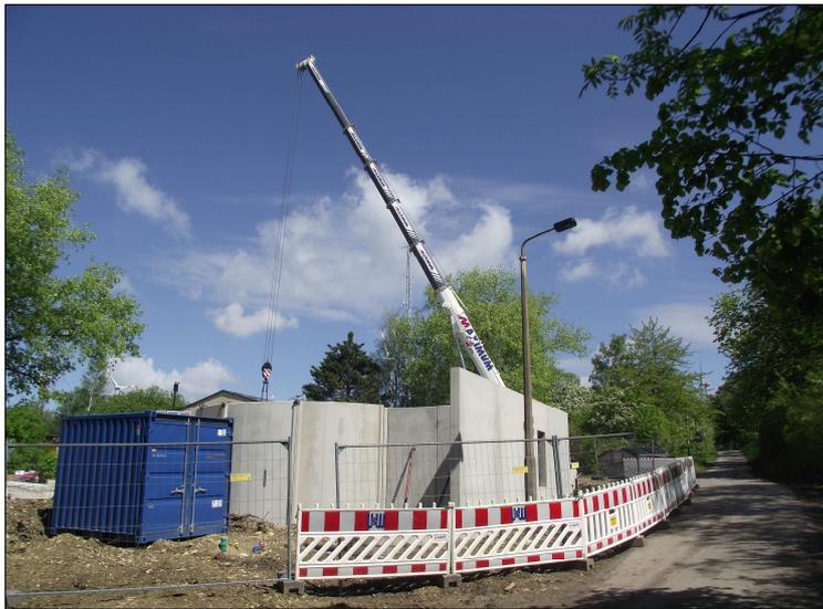
Nach dem Abriss des alten Hochbehälters am Butterberg platziert ein Telekran die Fertigbetonteile für den neuen Rundbau
