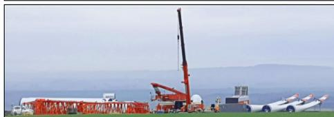
Nach mehrjährigem Wettstreit mit dem Windpark Druiberg, der 2021 durch eine gemeinsame Vereinbarung beigelegt wurde, errichtet die Itzehoer Firma SAB derzeit auf dem Rohrsheimer Druiberg eine VESTAS-Windkraftanlage vom Typ V 150 mit 125 m Nabenhöhe und 5,6 MW Generator.
