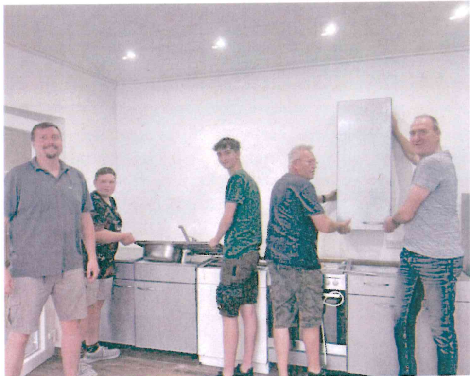
Oliver (links) und Olaf Beder (rechts) bauen mit Unterstützung von Tarje Panke, Eric Linkohr und Rüdiger Hetz (von links) die neue Küche im Badersleber Schützenheim auf.
