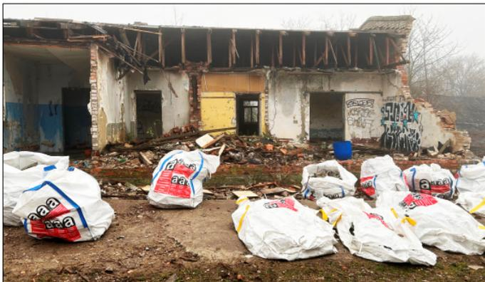
Rund 16 Tonnen Asbest wurden von dem beauftragten zertifizierten Entsorgungsfachunternehmen gesammelt und entsorgt in speziellen Asbest-Bigbags mit der Aufschrift „ACHTUNG ENTHÄLT ASBEST“ - Behältern geschlossen halten
