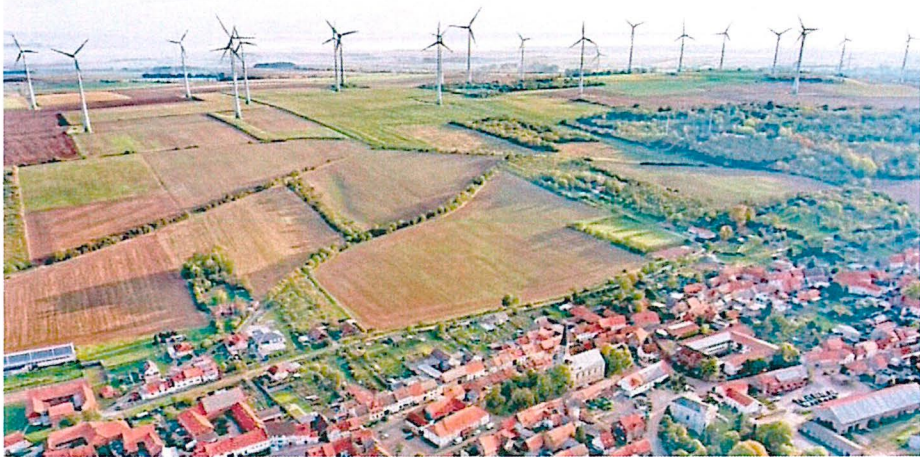
Auf dem Druiberg oberhalb von Dardesheim werden bald weniger, aber höhere und leistungstärkere Windräder stehen.
