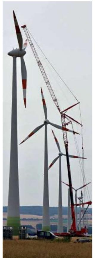
Der Riesenkran ist bereit, aus 114 Metern Höhe Rotor und andere Aufbauten des Windrads abzuseilen.
