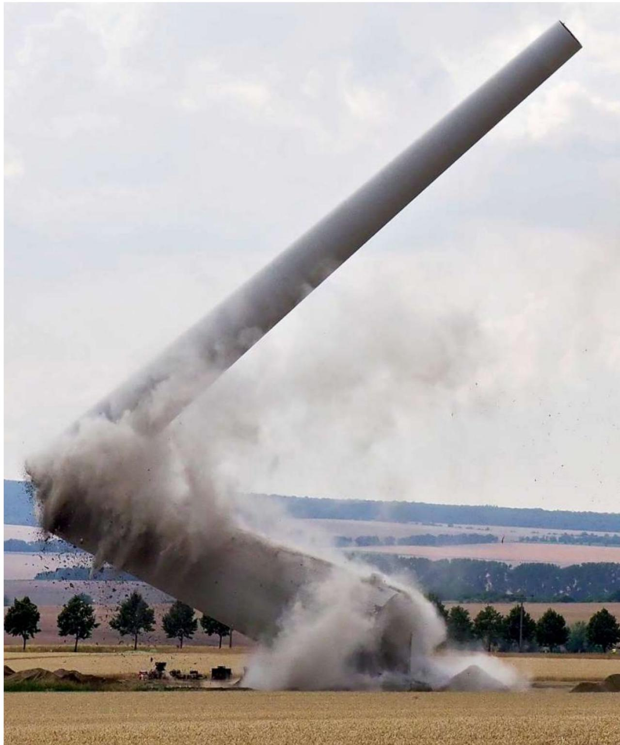
Wie ein Taschenmesser klappt der 84 Meter hohe Turm durch die Explosion von fünf Kilogramm Sprengstoff zusammen.
