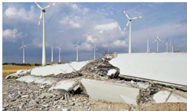
Die Trümmer des Turms Minuten nach seiner Sprengung am Boden. Das Material wird recycelt und auf dem Windparkareal weiterverwendet.
