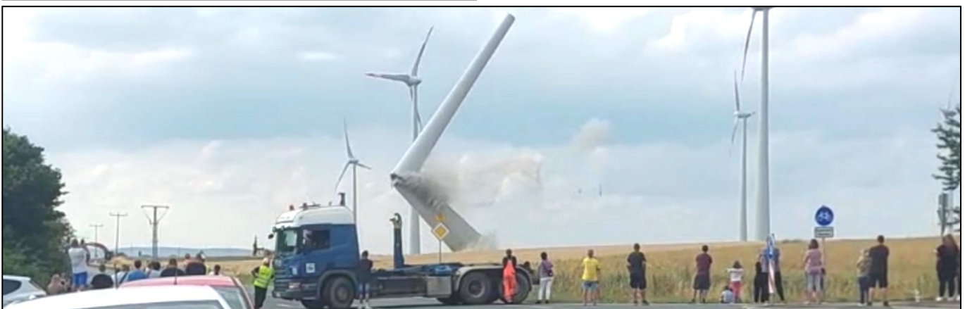
Mit Spannung wurde von vielen Bürgern die Sprengung des ersten Anlagenturms am Druiberg erwartet. Dazu wurde am 14. Juli zeitweilig die Bundesstraße 79 und die Kreisstraße K 1335 gesperrt. Abends um 18 Uhr erfolgte die Detonation und der Turm fiel dann innerhalb weniger Sekunden kontrolliert in sich zusammen. Schon kurz darauf starteten die Arbeiten zur Verwertung des zu Boden gegangenen Materials.
