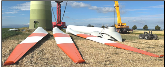
Nach 20 Jahren erfolgreicher Arbeit zur Windstrom-Produktion haben die rot-weißen Rotorflügel „ausgedient“ und liegen nun für Weiterverwendung, Recycling oder thermische Verwertung bereit.
