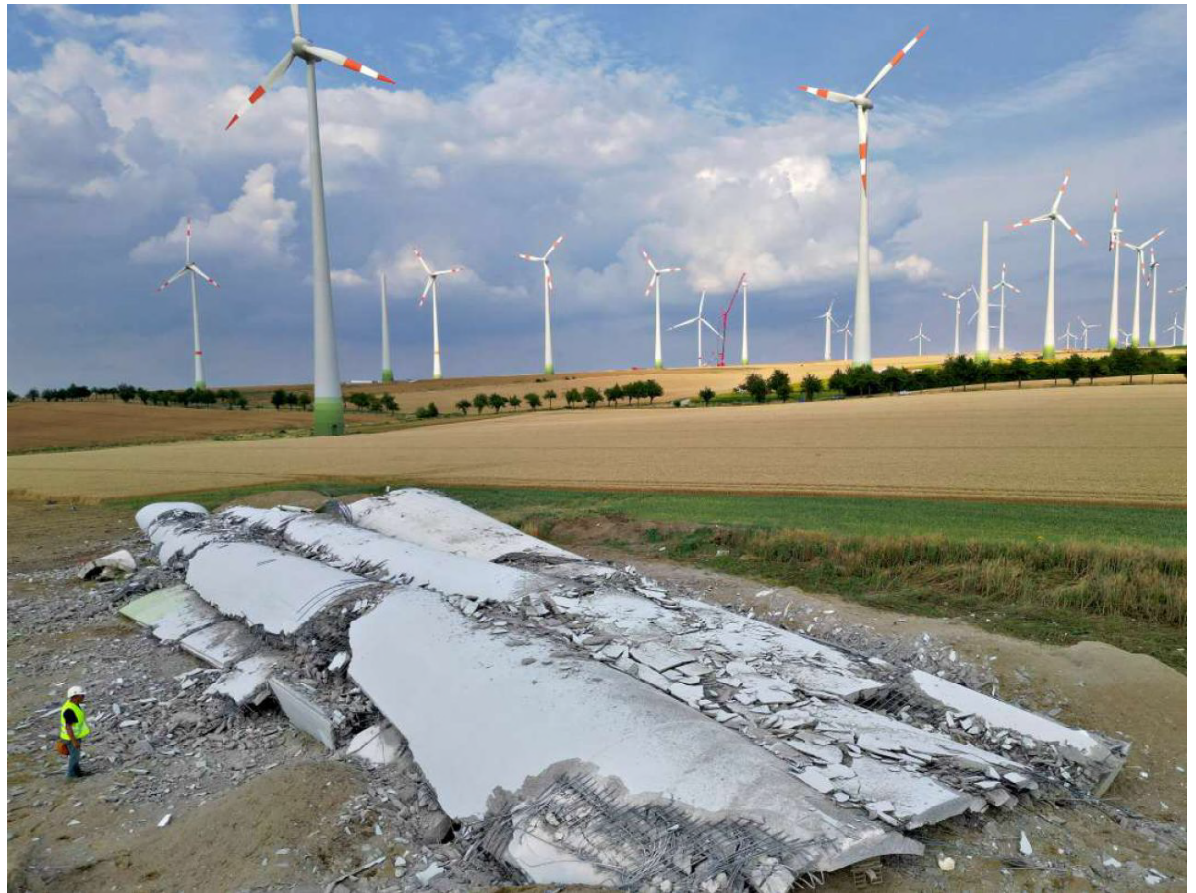
Im Windpark Druiberg bei Dardesheim hat das Repowering mit der Sprengung alter Anlagen begonnen: Sie werden durch neue, leistungsstärkere Windräder ersetzt.
