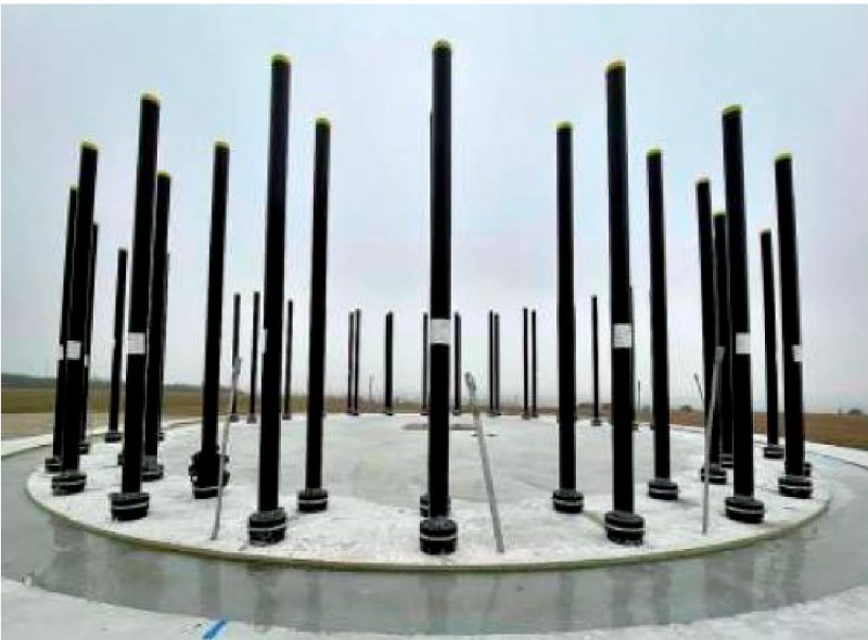
Das Fundament misst 24 Meter Durchmesser, der Außendurchmesser des Turms elf Meter. Die Betonelemente werden mit Litzen verspannt.
