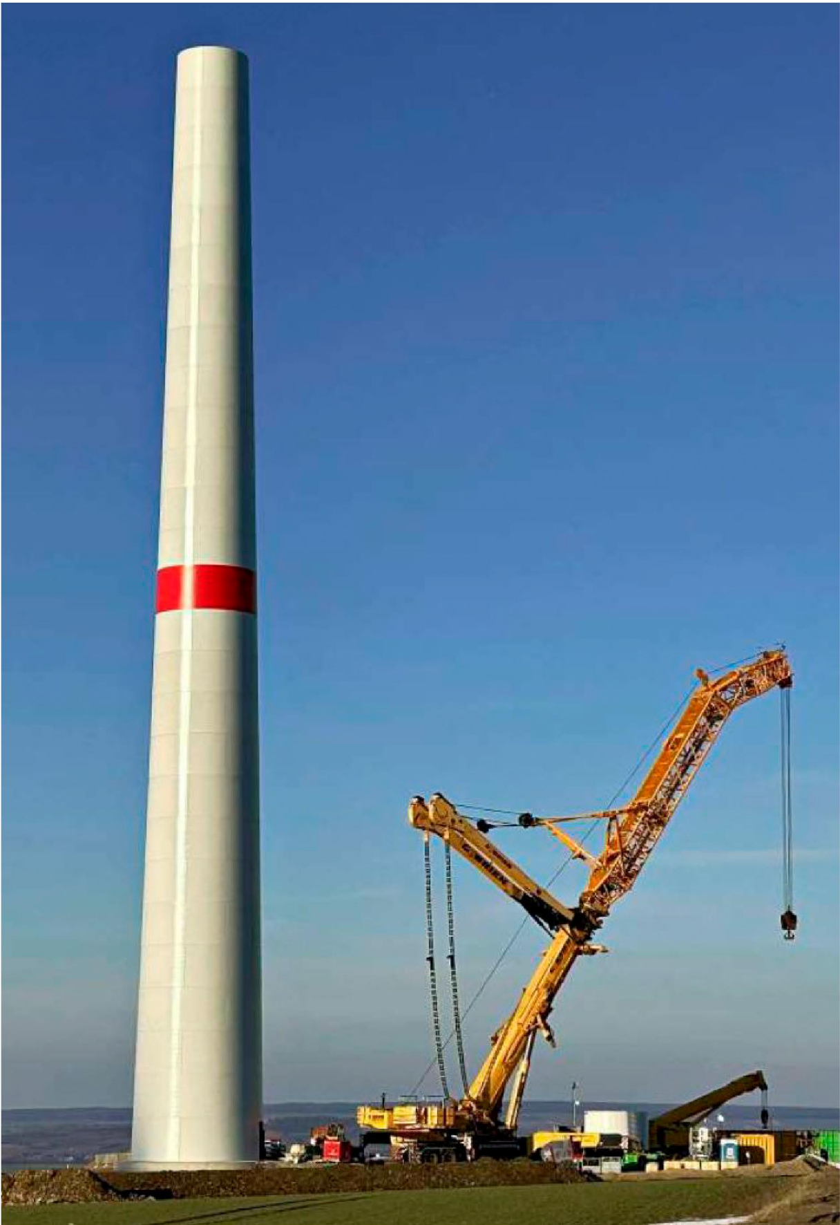
Der erste Betonturm auf dem Druiberg steht, und der große Baukran kann umgesetzt werden.
