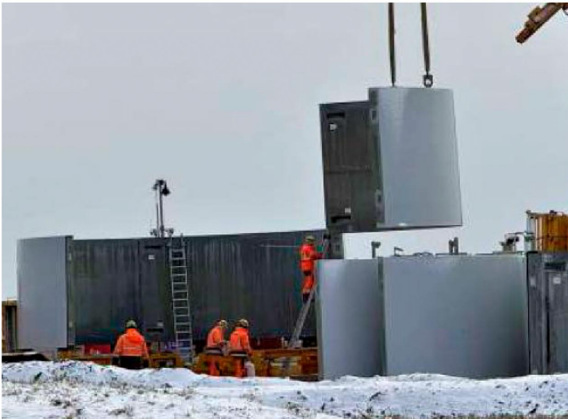
Der Bau eines Turms beginnt. Insgesamt rund 30 Leute verschiedener Firmen und Gewerke arbeiten derzeit auf dem Druiberg.
