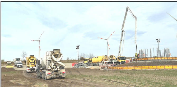
Für jedes neue Fundament der geplanten Neuanlagen vom Typ ENERCON E 160 mit 24 Metern Außendurchmesser wurden ca. 900 Kubikmeter Beton, also etwa 110 Mischfahrzeuge mit je 8 m³ bzw. knapp 20 Tonnen Beton benötigt
