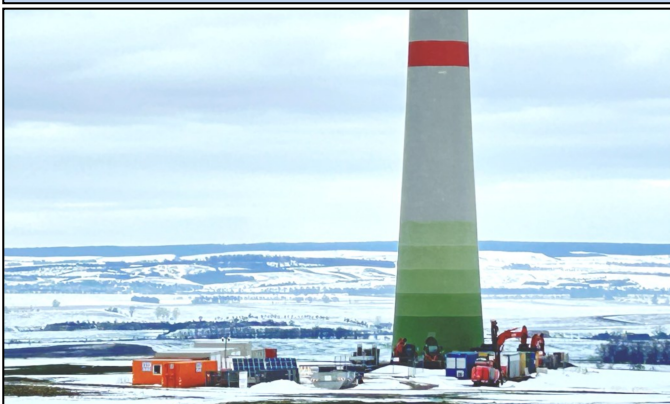
Ab Mitte Dezember gingen die Baustellenarbeiten in eine unerwartet lange Winterpause – hier das Baubüro an der Großanlage E 112. Ab der letzten Januarwoche wurden alle Windparkwege morgens früh vom Schnee geräumt, um nicht in Arbeitsverzug zu geraten.
