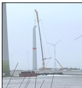
Bei ungünstigen Wetterbedingungen im Januar wurden die zahlreichen Beton-Turmteile Segment für Segment vom Großkran emporgezogen (Foto: Horst Müller)
