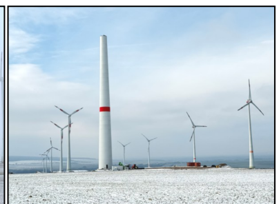
Auf die unteren Spannbeton-Elemente folgen noch drei weitere stählerne Turmteile. Statt bisher 113 Metern bei den alten Windrädern erreichen die neuen Türme dann eine Gesamthöhe von 166 m. Mit zusätzlich 80 m Blattlänge beträgt die Rotorblattspitzenhöhe der Neuanlagen jeweils 246 m.
