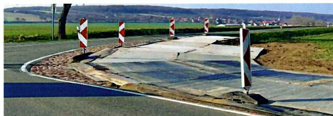
An der Einmündung nach Dingelstedt in Arbketal sind spezielle Aluminiumplatten ausgelegt und montiert worden, damit die langen Schwerlasttransporte problemlos und sicher abbiegen können, ohne im weichen Erdreich einzusinken oder sich festzufahren. FOTO: MARIA LANG
