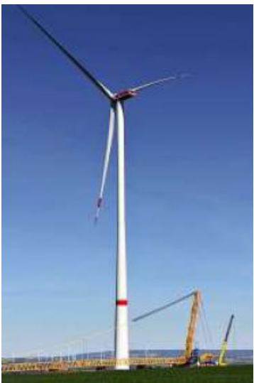
Das erste neue Windrad auf dem Druiberg ist komplett. FOTO: WINDPARK
