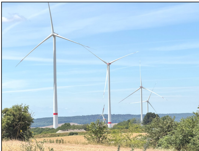
Der neue BürgerEnergiePark nimmt Gestalt an: Hier ein Blick von der Baderslebener Druiberg-Anhöhe mit Blick nach Westen in Richtung Fallstein mit den fertig montierten Neuanlagen DaBa4, DaBa6, DaBa8 und DaBa10
