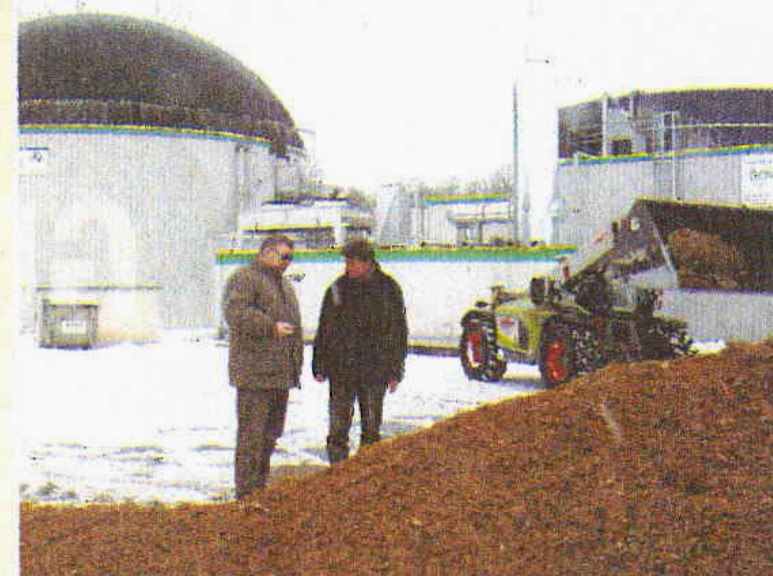
Alles alternativ: Die Biogasanlage in Zilly. 25 t Maisschnitzeln werden hier pro Tag verstromt.
