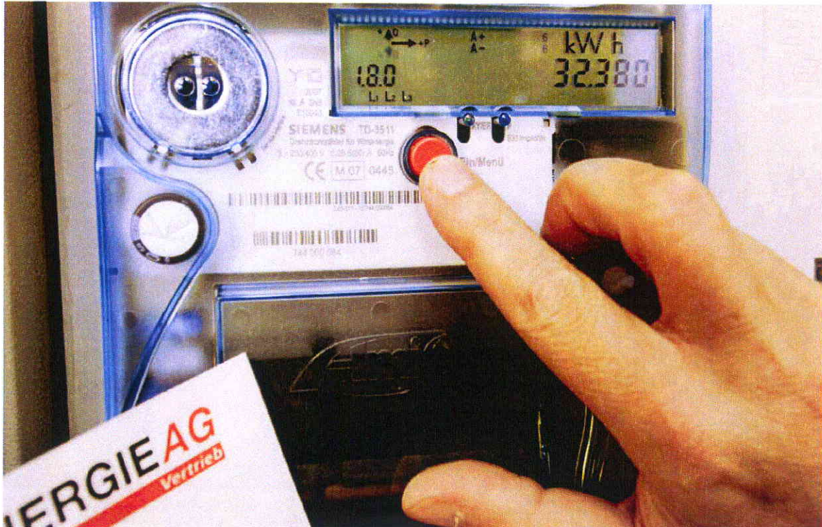
Mit intelligenten Stromzählern, können Kunden ihren Stromverbrauch zeitgenau prüfen, steuern und so ihre Kosten senken.
