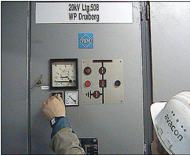
Ein spannender Moment: Die eingeschaltete Spannung kann schwarz auf weiß auf dem Voltmeter abgelesen werden.
