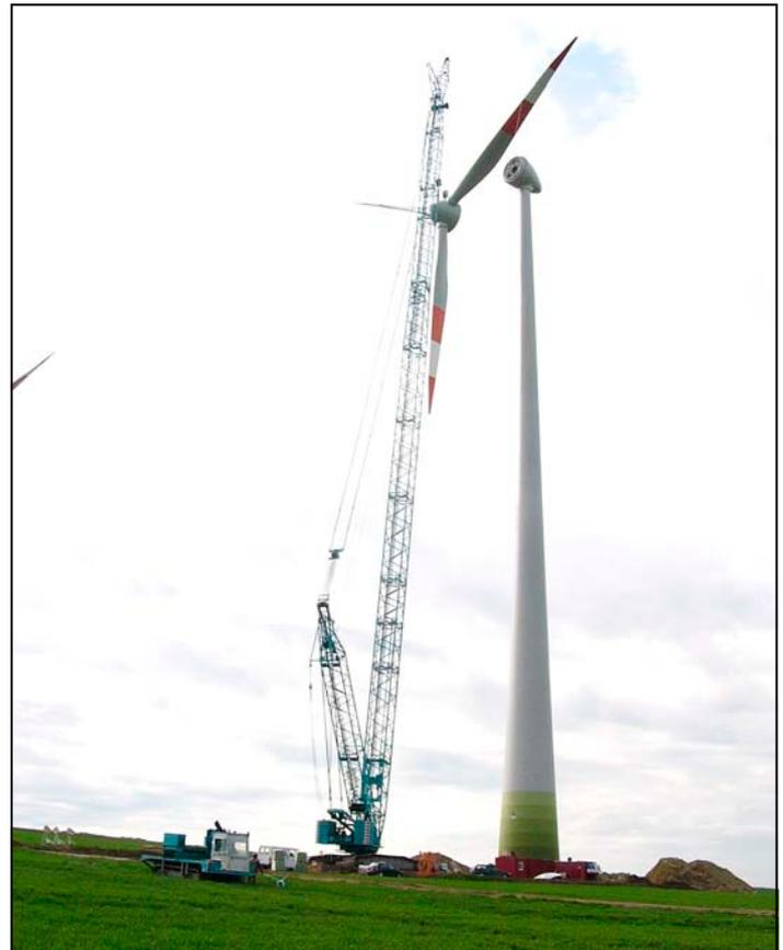
Der Kopf der 7. Windenergieanlage wird angehoben und montiert
