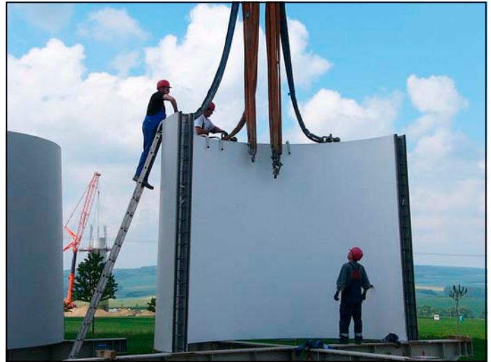
Im Vordergrund wird eine Halbschale des untersten Turmsegmentes zur Umsetzung auf das Fundament der Telekran bereit gemacht; im Hintergrund zieht ein anderer Telekran einen weiteren Turm hoch.
