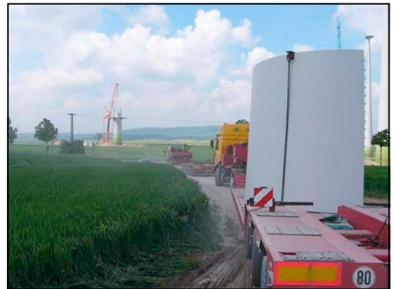
Im Vordergrund wird eine Halbschale des untersten Turmsegmentes zur Umsetzung auf das Fundament der Telekran bereit gemacht; im Hintergrund zieht ein anderer Telekran einen weiteren Turm hoch.
