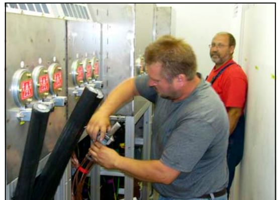
Monteure führen die Kabel in die Schaltschränke
