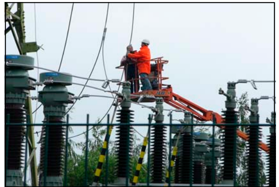
Inbetriebnahme des Umspannwerkes Wasserleben
