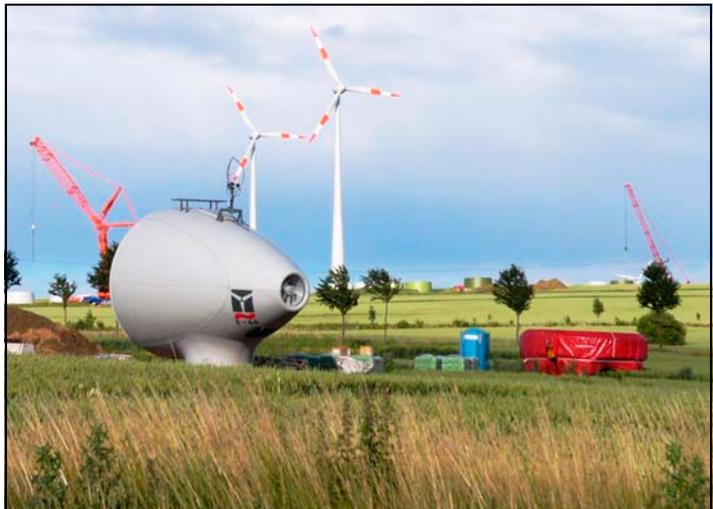
Bald wird der Telekran die Gondel und den Generator (noch in roter Schutzfolie verpackt) auf die Turmspitze hieven
