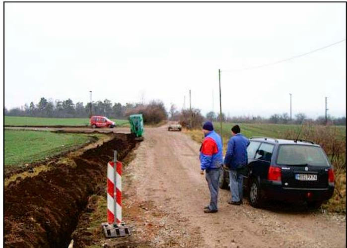
Nachdem Künne elektrotech die Erdverkabelungsarbeiten abgeschlossen hat, kann mit der Demontage der weiteren Freileitungsmasten auf dem östlichen Druiberg begonnen werden.
