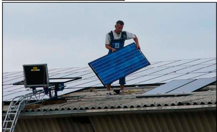
In kaum fünf Minuten pro Stück wurden die Panels in mehreren Reihen auf vorbereiteten Schienen befestigt
