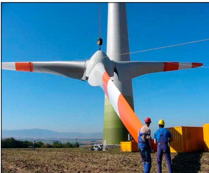
Zwei ENERCON-Monteure befestigen den Rotor am Kranhaken und führen den Rotor in die richtige Richtung nach oben
