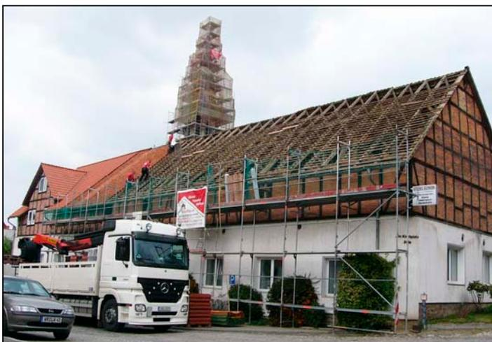
Das Dach von elektrotech Künne wird vor Installation der Fotovoltaik-Module neu eingedeckt
