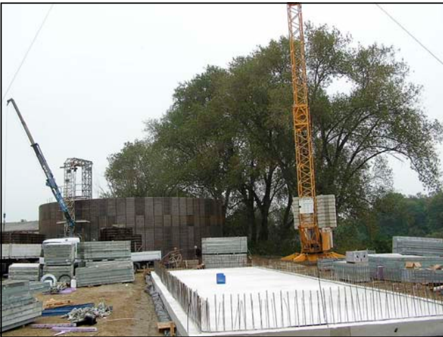
Das Fundament des Blockheizkraftwerks
