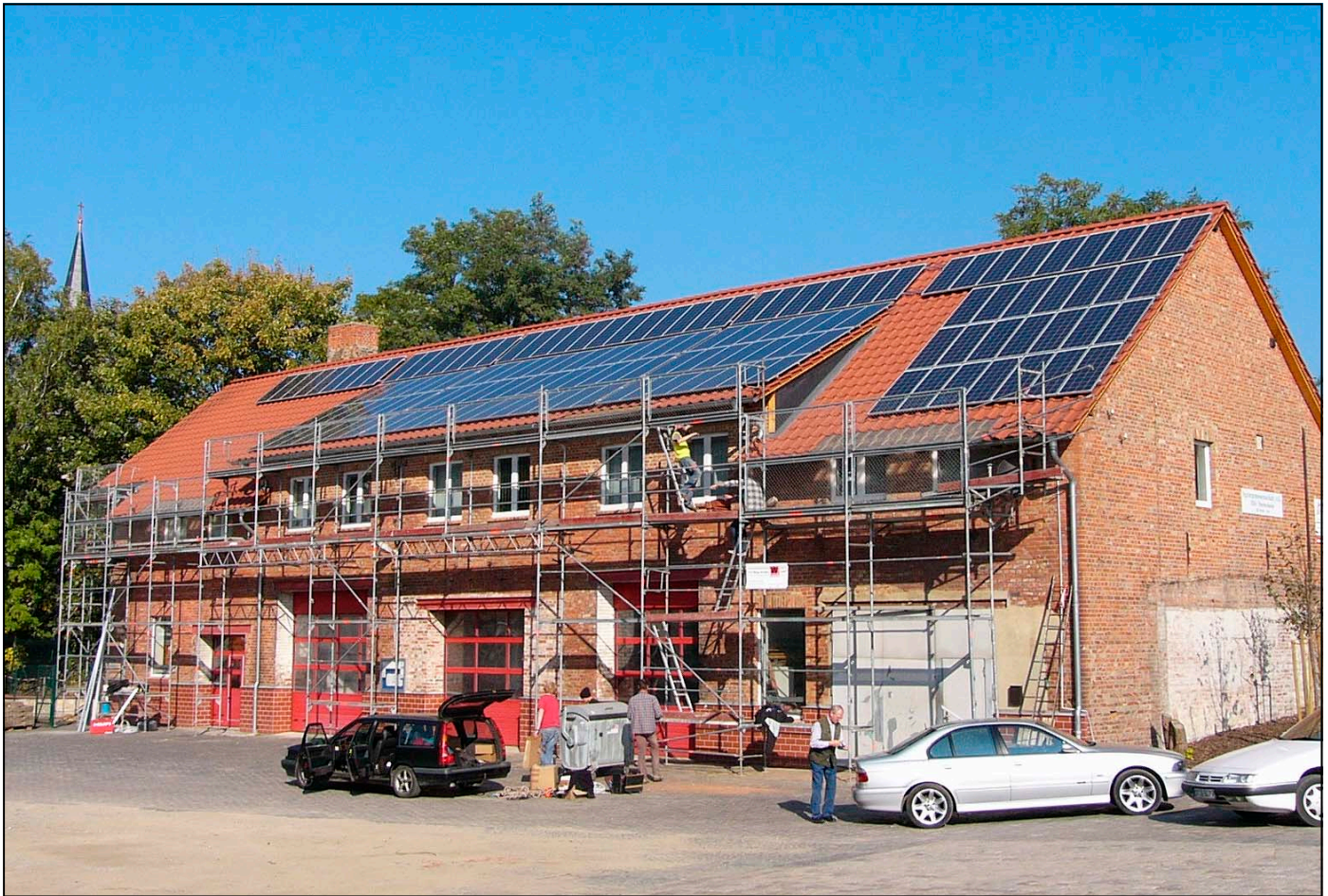
Regelr Betrieb mit rund 10 Mitarbeitern herrschte während des Anlagenbaus vom 15. – 17. Oktober am Gemeinschaftshaus, häufig unterstützt von Bürgermeister Rolf-Dieter Künne, vorn rechts im Bild
