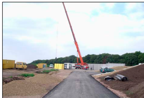
Aufbau der Fertigteilbehälter in Beierstedt
