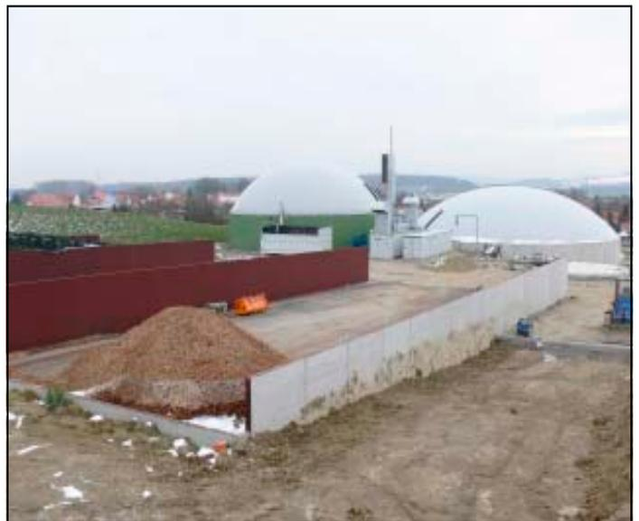
Vorn: 3 Vorrats – Silos von je 1.000 m<sup>3</sup> für Hackschnitzel und Mais. Hinten jeweils mit Kuppen der Fermenter (links) und das 5.200 m<sup>3</sup> fassende Gärgut-Zwischenlager (rechts)
