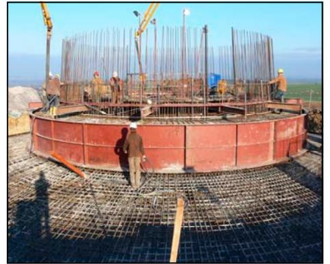
Die Betonbauer leiten den dickflüssigen Speis aus den Misch-LKW über zwei Betonpumpen oben in die Fundamentbewehrung
