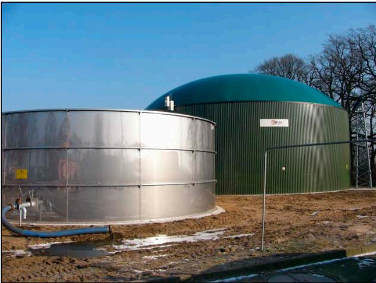
Links im Bild das silberne Roggenlager und rechts der Fermenter für die Biogasgärung
