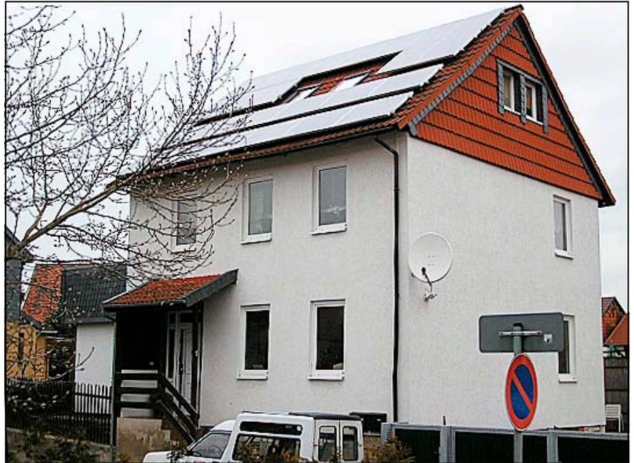
Bei der zweiten Photovoltaikanlage der Firma Elektrotechnik ist bis auf die Fenster das gesamte Süddach mit Solarmodulen belegt
