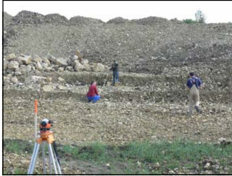
Im südwestlichen Eingangsbereich der ehemaligen Radarstation entsteht eine Freilicht-Veranstaltungsbühne (Eventbereich)
