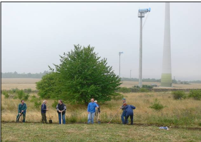
Auch an der östlichen Grenze des zukünftigen Energieparks wird an der Erstellung eines Aussichtspunktes gearbeitet
