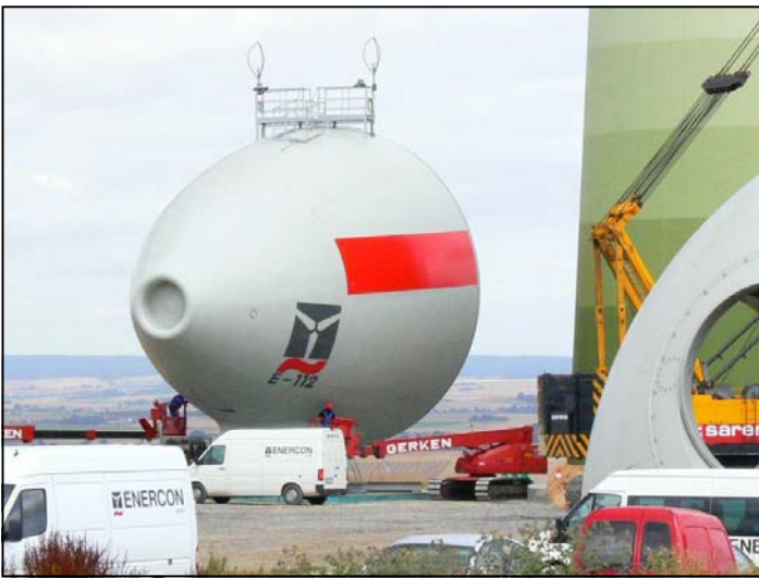
6.000 Kilowatt noch am Boden - die dreistöckige Generatorgondel der E 112 mit nach oben anschließendem „vierten Stock“: eine kleine Aussichtskanzel für etwa 6 Personen
