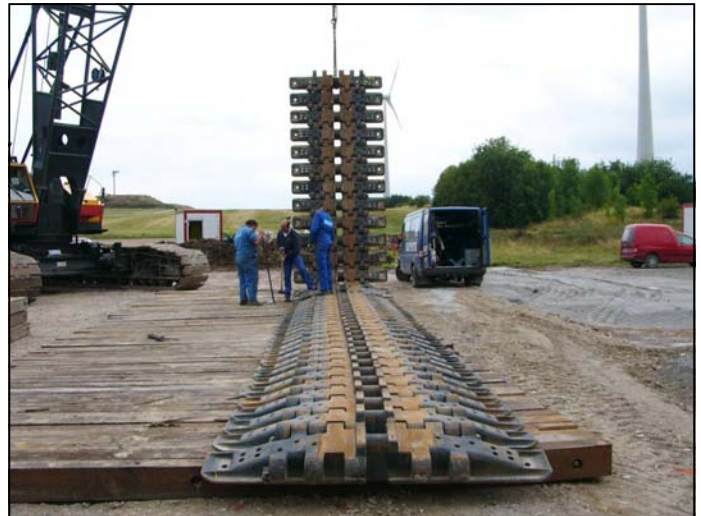
Allein eine Raupenkette des Mammutkrans ist schwer wie 100 Autos - hier beim Beginn des Kranaufbaus mit einem 160 Tonnen Hilfskran und einem 200 Tonnen Telekran
