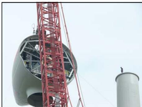
Oben wird das Maschinenhaus bereits von einem Pionier der Mannschaft an der Turmspitze erwartet und per Funk in die richtige Position gelotet
