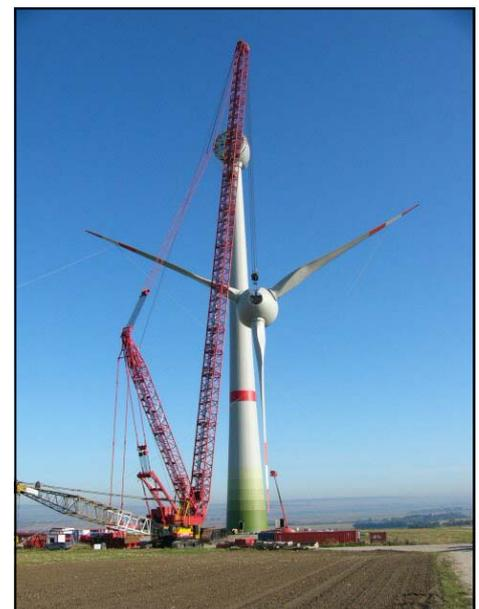
Vormontiert am Boden wurde der komplette dreiflügelige Rotor vom Raupenkran gezogen und dann passgenau vor den Generator gesetzt
