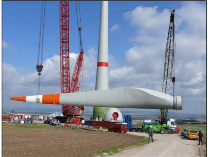
Der Raupenkran und ein weiterer Telekran entladen die je 54 Meter langen Rotorblätter mit rot-weiß-roter Flugsicherheits-Farbkennzeichnung
