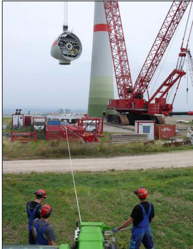
Langsam, Meter für Meter, und an langen Seilen austariert von 2 Balance-Teams wird das 250 Tonnen schwere Maschinenhaus vom Raupenkran hochgezogen
