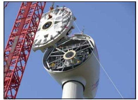
Balance-Akt Nr.2: Nach Befestigung des Maschinenhauses wird der in vier Teilen zur Baustelle angelieferte 6 MW – Generator in Position gebracht
