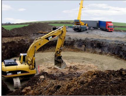
Schwere Baufahrzeuge bearbeiten die rund 20 Meter Durchmesser großen Fundamentgruben: Aushub, Bodenverstärkung und Betonbau für das Windrad-Fundament
