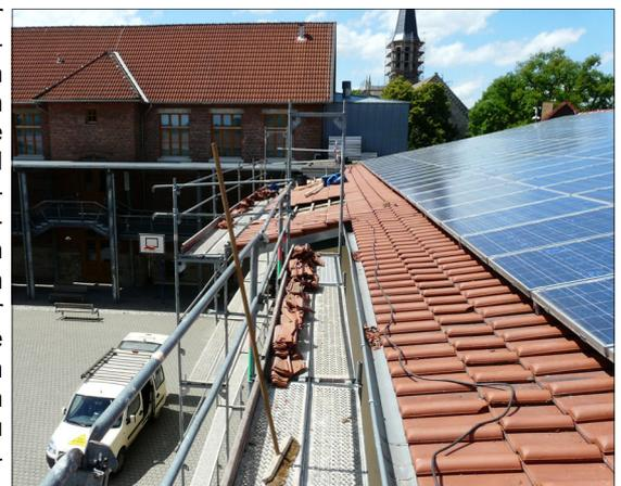
Aufgrund von Installationsfehlern mussten zahlreiche zerstörte Dachziegel und die gesamte Unterkonstruktion auf dem Schuldach erneuert werden
